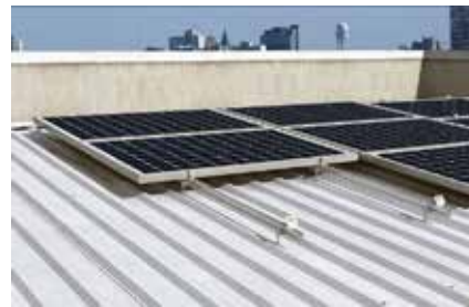
Telepítés ipari tetőre
