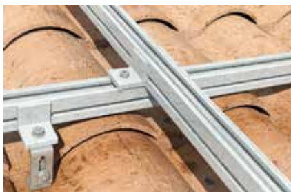
Solar-fish profilok keresztcsatlakozása
