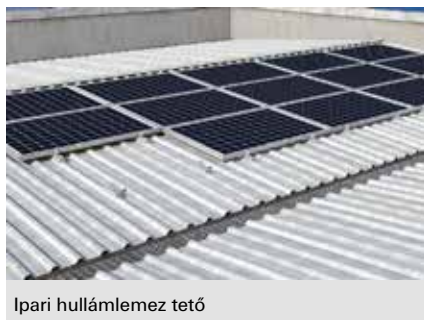
Részlet: napelem telepítés Solar 40/30 profillal
