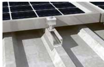
Részlet: napelem telepítés Solar 40/30 profillal
