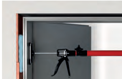
Foaming door frames
