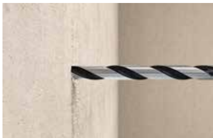
Furatkészítés betonba
