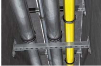
Csörögzés menekülő útvonalaknál
