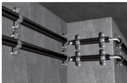
Acélerősítésű csövek rögzítése
