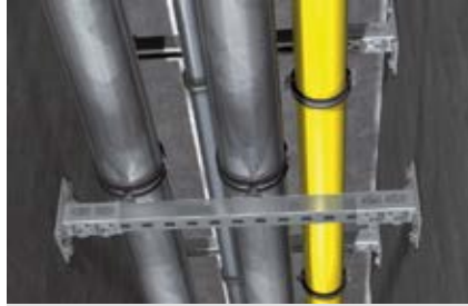
Csővezetékek rögzítése
