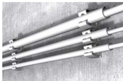
Műanyag szigetelőcsövek rögzítése
