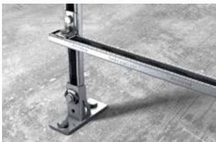
Szerelősín rögzítés padlón
