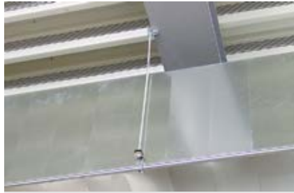
Légcsatorna függesztése acél gerendáról
