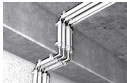
Műanyag szigetelőcsövek rögzítése
