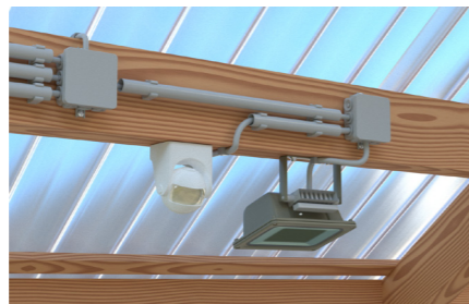
Elosztó dobozok, kábelek és csövek
