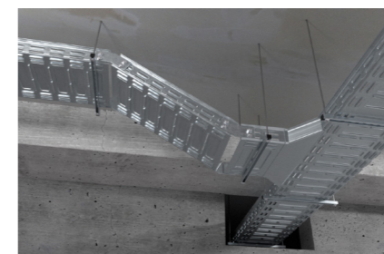
Függeszett kábeltálcák
