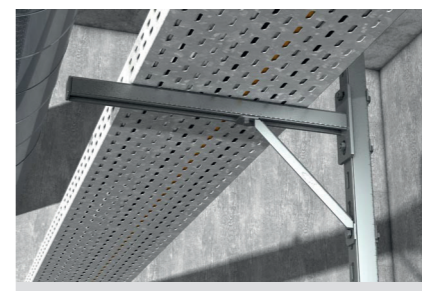
Kábeltálcák rögzítése konzolon
