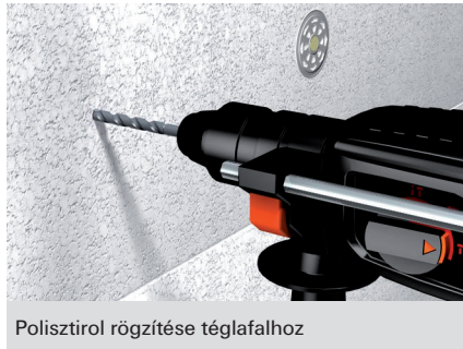
Polisztirol szigetelőtábla rögzítése üreges mészhomok téglára
