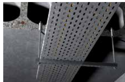
Kábeltálcák mennyezeti rögzítése
