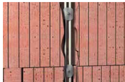
Vezetékrögzés falhornyokba
