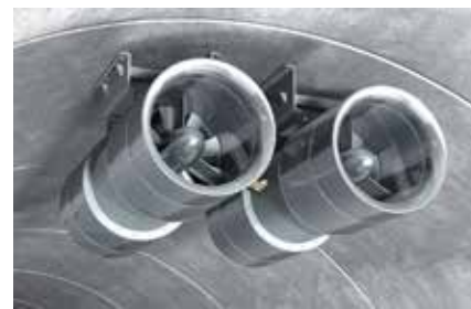
Alagút szellőztető berendezések
