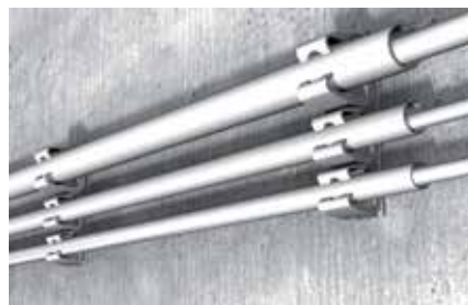
Műanyag szigetelőcsövek rögzítése
