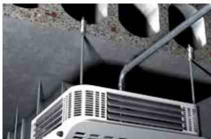
Légkondicionálók mennyezeti rögzítése
