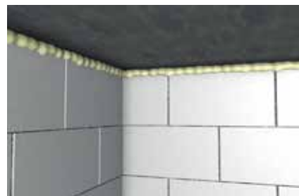
Tömítések szerkezeti munkáknál
