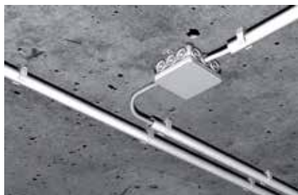
Műanyag szigetelőcsövek rögzítése
