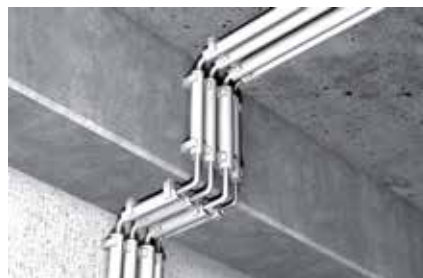
Műanyag szigetelőcsövek rögzítése
